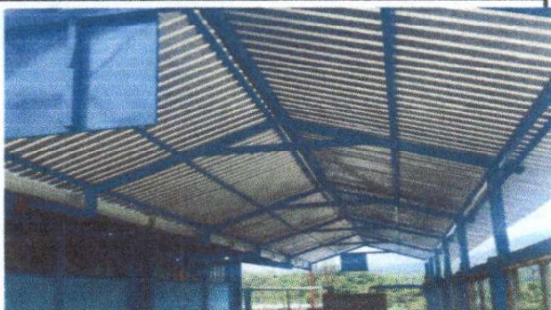
Foto 1: Sustrucción de lámina por lámina troquelada aluzinc calibre 26, sustrucción de capote de lámina para lámina troquelada (patio)
