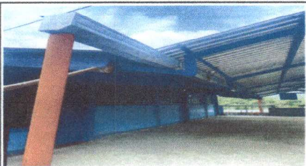
Foto 5: Sustrucción de canal (patio)
