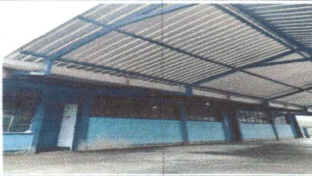
Foto 2: Sustrucción de estructura de soporte de madera por metal (patio)
